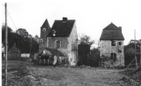
État du site vers 1970 lors de la construction du supermarché (Liège, Archives de la Commission royale des Monuments, Sites et Fouilles)
