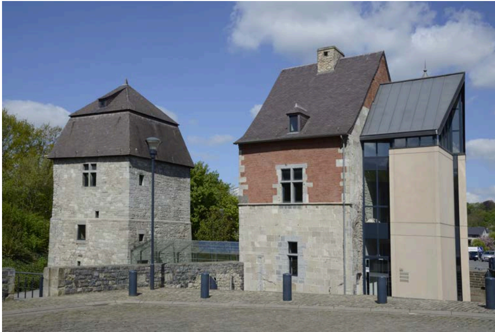
Réaménagement du site par l'intégration d'une verrière reliant les deux bâtiments et d'une extension contemporaine
