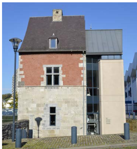
Unique bâtiment subsistant à la campagne de construction d'Englebert Lamistant (auquel a été ajouté une annexe contemporaine)
